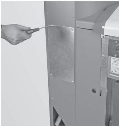
Fig. 83 Schrauben entfernen, Revisionsdeckel abnehmen
