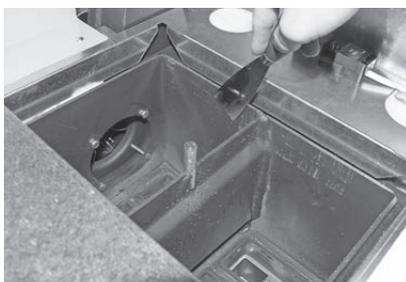
Fig. 72 Nachheizflächen reinigen
