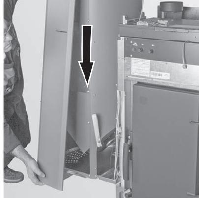
Fig. 82 Blende nach unten schieben und abnehmen (Bajonettverschluss)
