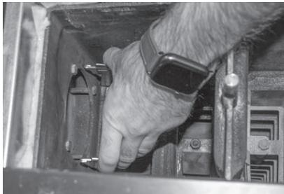
Fig. 68 Umlenblech herausnehmen (nur bei Pelletskessel mit elektrostatischem Staubabscheider)
