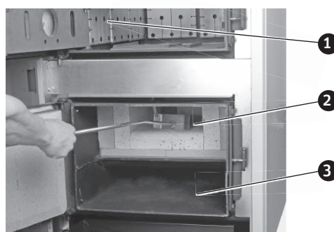
Fig. 55 Asche aus der Brennkammer und Ascheraum entfernen
