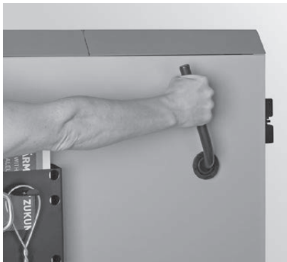
Fig. 39 Hebel-Heizflächenreinigung 5–10 x betätigen – LogWIN Klassik
