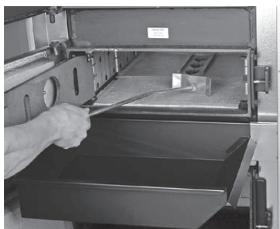
Fig. 54 Aschelade einhängen, Asche entfernen
