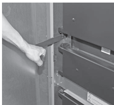
Fig. 52 Hebel-Heizflächenreinigung 5–10 x betätigen – LogWIN Klassik pellet ready
