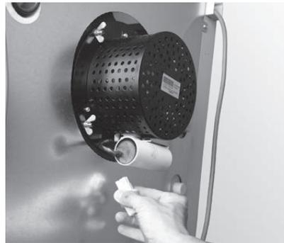
Fig. 35 Gebläsestecker abziehen und Flügelmuttern entfernen
