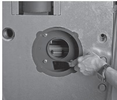
Fig. 37 Gebläsekasten innen reinigen
