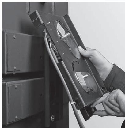
Fig. 30 Accrocher la régulation d'air en haut et la visser en bas
