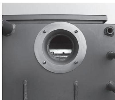
Fig. 13 Joint sur la chaudière
