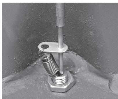
Fig. 56 Fixer la sonde Thermocontrol avec un ressort
